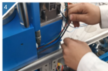
4 将泵和电磁阀的电源线卸下。
