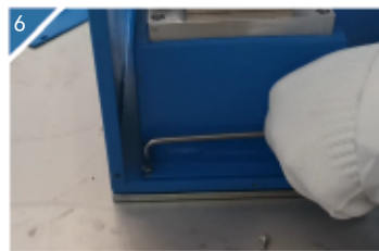
6 拆下泵的固定螺丝。
