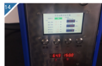
14 设备会按照程序，加压后保压一段时间，自动泄压。
